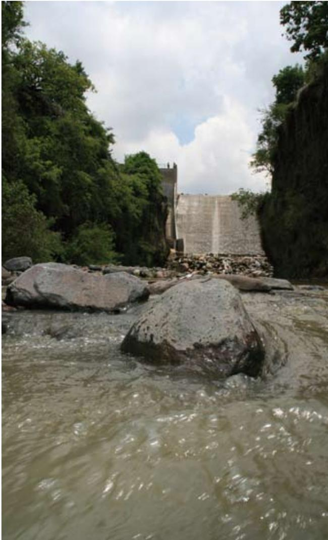
La cortina es del tipo gravedad de concreto convencional, de talud vertical en el paramento mojado, con un vertedor de cresta libre tipo Creager de 20 m de longitud, alojado sobre el cuerpo de la cortina, con talud en la rápida de 0.75:1. Los muros guía son de 1.50 m de altura, rematando en una cubeta de lanzamiento tipo Salto de Ski de 6 m de radio, construido con concreto armado.
