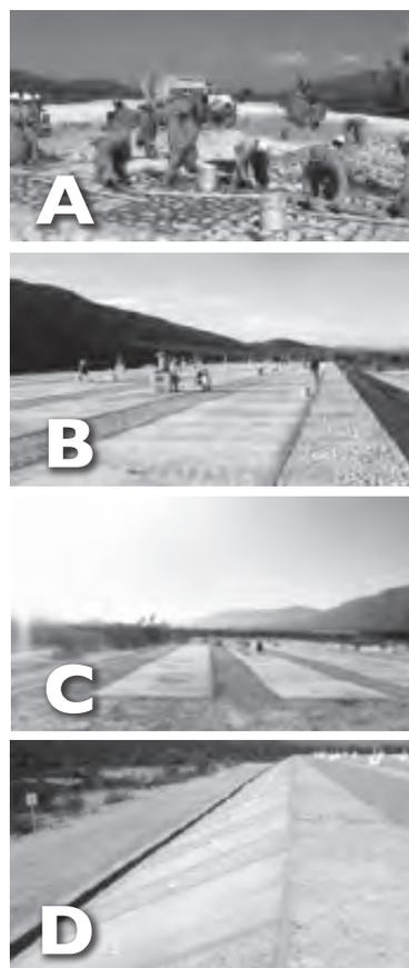
▲ **Figura 21.** Vistas del sistema multibarrera construido en el predio La Pedrera. A) Colocación de las piedras para el zampeado. B, C y D) Vistas de la tubería de ventilación, desagüe y monitoreo (Fuente: SEMARNAT y GESLP, 2009).
