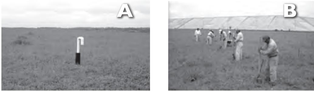
**Figura 20.** Reforestación en la zona de la celda de estabilización. A) Cubierta vegetal en la corona de la celda y ducto de ventilación. B) Siembra de especies vegetales en los alrededores (Fuente: PGPB).
