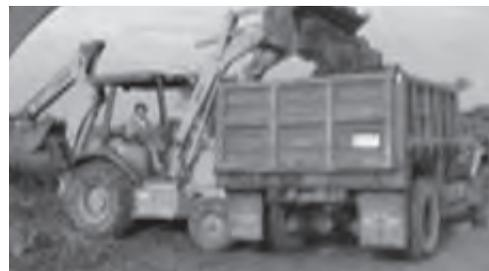
▲ **Figura 25.** Eliminación de la capa de hidrocarburos del fondo de la presa Agua de Minas (Fuente: PGPB).
