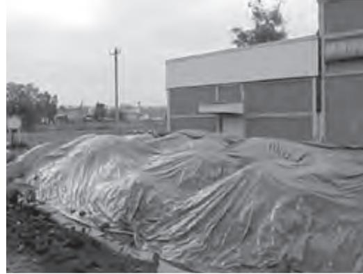
▲ **Figura 16.** Operación de biopilas en los extalleres de FNM en Aguascalientes. Las biopilas se cubrían para conservar la humedad necesaria para los microorganismos. (Fuente: INSECAMI).
