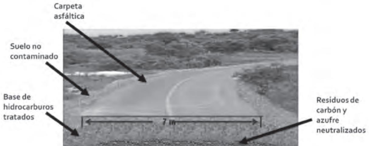
Figura 31. Esquema que indica el rescate propuesto para las vías de acceso de la UMIT.
