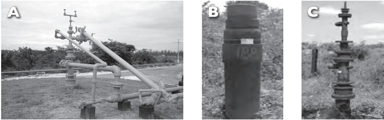
**Figura 28.** Estado de los pozos de extracción de azufre. A) Vista de un pozo de extracción en condiciones ideales de operación donde se observan las tuberías subterráneas de inyección de agua y de extracción de producto. B y C) Pozos abandonados sin producto. (Fuente: PGPB).
