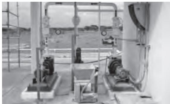
▲ **Figura 18.** Laboratorio para la neutralización con óxido de magnesio de los lixiviados ácidos remanentes de la celda de estabilización.
