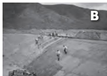
**Figura 5.** Celdas de confinamiento en el Predio La Pedrera. A) Excavación de una celda. B) Preparación del fondo de las celdas con impermeabilizante (Fuente: SEMARNAT).
