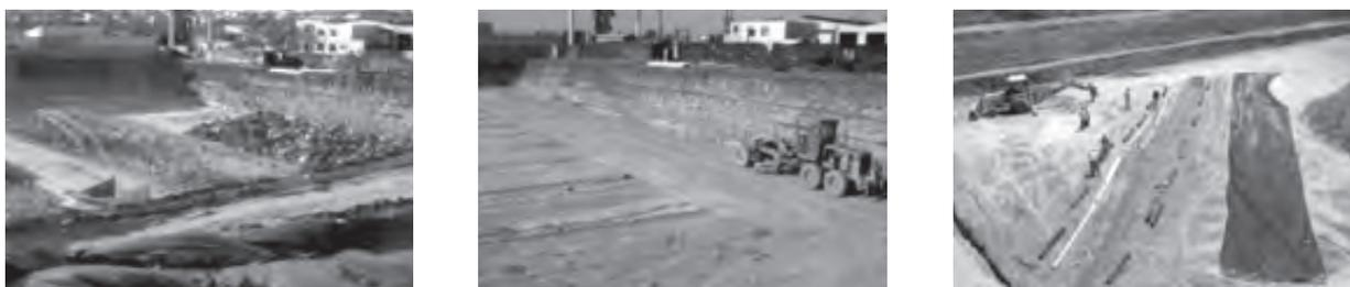
**Figura 14.** Colocación de los escombros en la fosa y el sistema de monitoreo de lixiviados.
