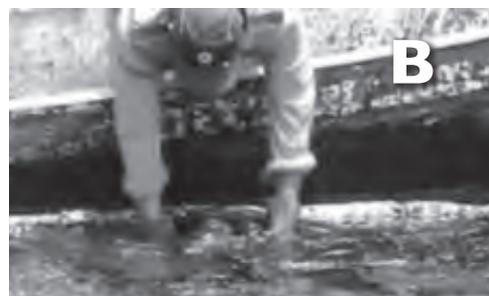
▲ **Figura 24.** Eliminación de los hidrocarburos de la superficie de la presa Agua de Minas. A) Aplicación de polvos orgánicos B) Recolección manual de los hidrocarburos (Fuente: PGPB).
