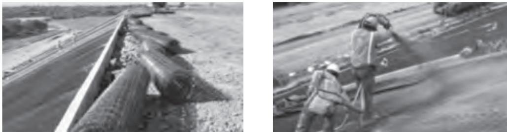
Figura 16. Construcción de la celda de estabilización. Colocación de la malla metálica electrosoldada (izquierda) y aplicación de concreto lanzado (derecha), (Fuente: PGPB).
