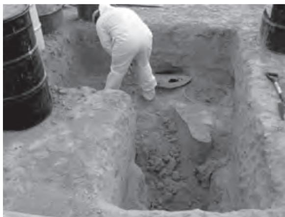
▲ **Figura. 15.** Excavaciones para retirar los residuos en las celdas de confinamiento (Fuente: SEMARNAT).
