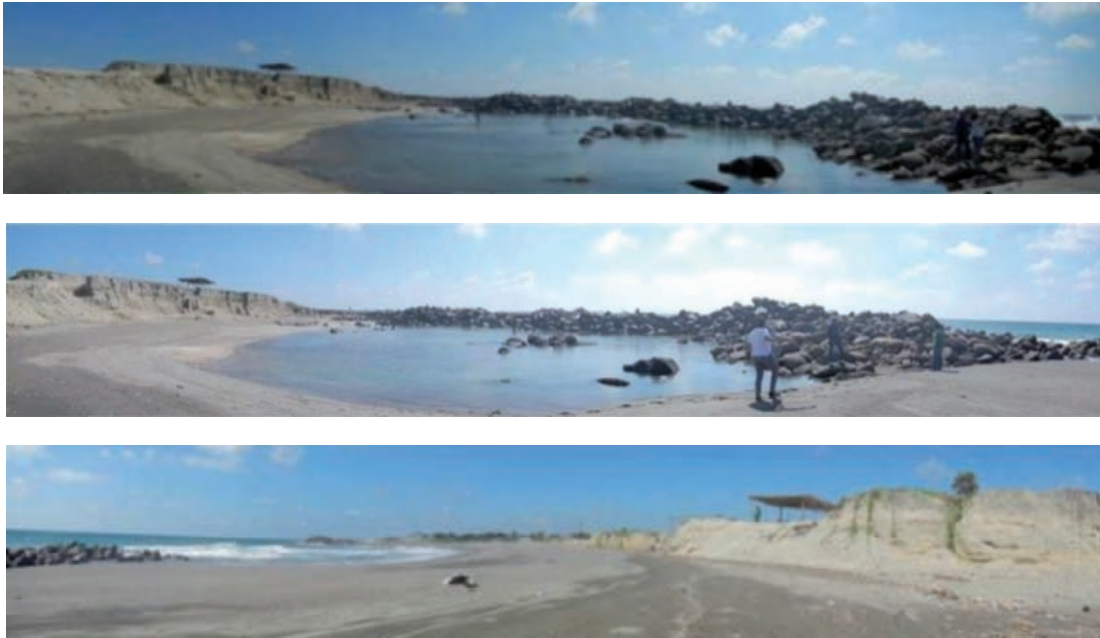
Figura 39. Playas de Puerto Madero, Tapachula, Chiapas. Erosión grave de playa ocasionada por escollera y espigones.
