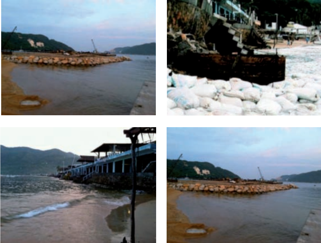
Figura 33. Daños ocasionado por la interrupción del transporte de sedimentos e intensificación del oleaje.
