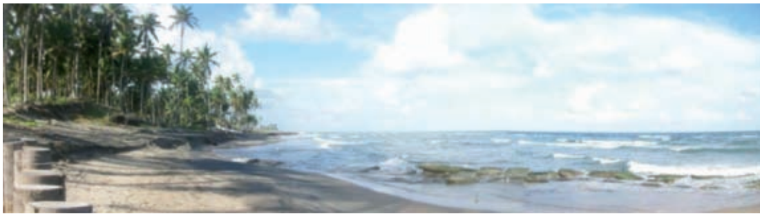
Figura 37. Playas de Tabasco erosionadas, se muestra el Faro en el piso.
