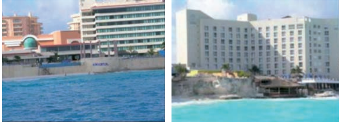
Figura 27. Aspecto en 2004 de dos segmentos de costa sin playa asociado a la ocupación de la zona de dunas.
