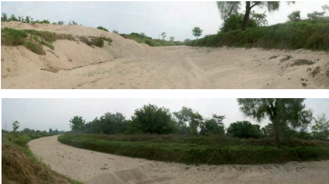
Figura 40. Cauce rectificando del Río Madre Vieja, Chiapas. El sedimento proveniente de la cuenca alta es atrapado entre los bordos del río, asolvando el cauce y evitando que la arena se disperse por la planicie costera, las dunas y la playa.
