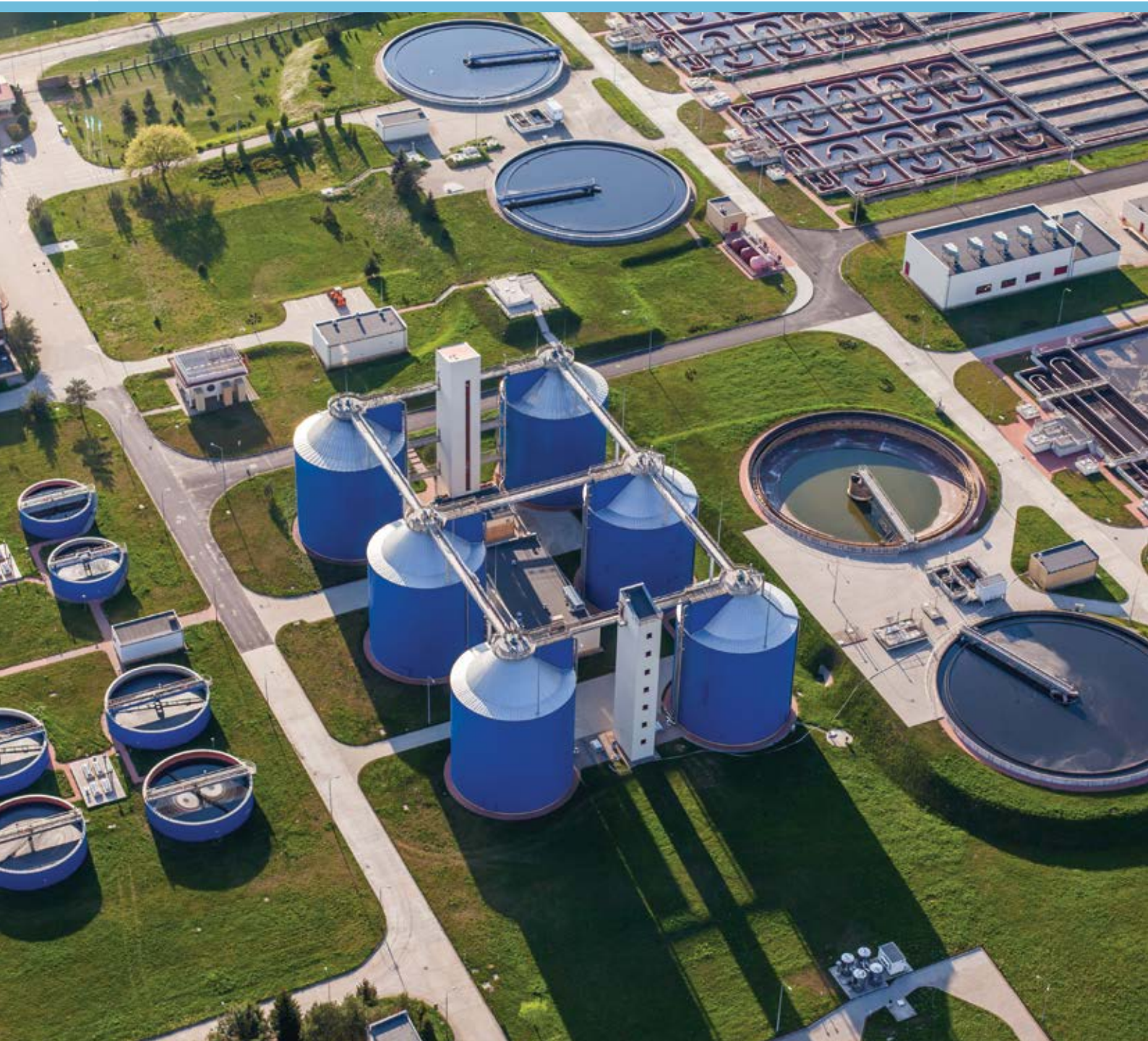
Vista aérea de una planta de tratamiento de aguas residuales en Breslavia (Polonia).
