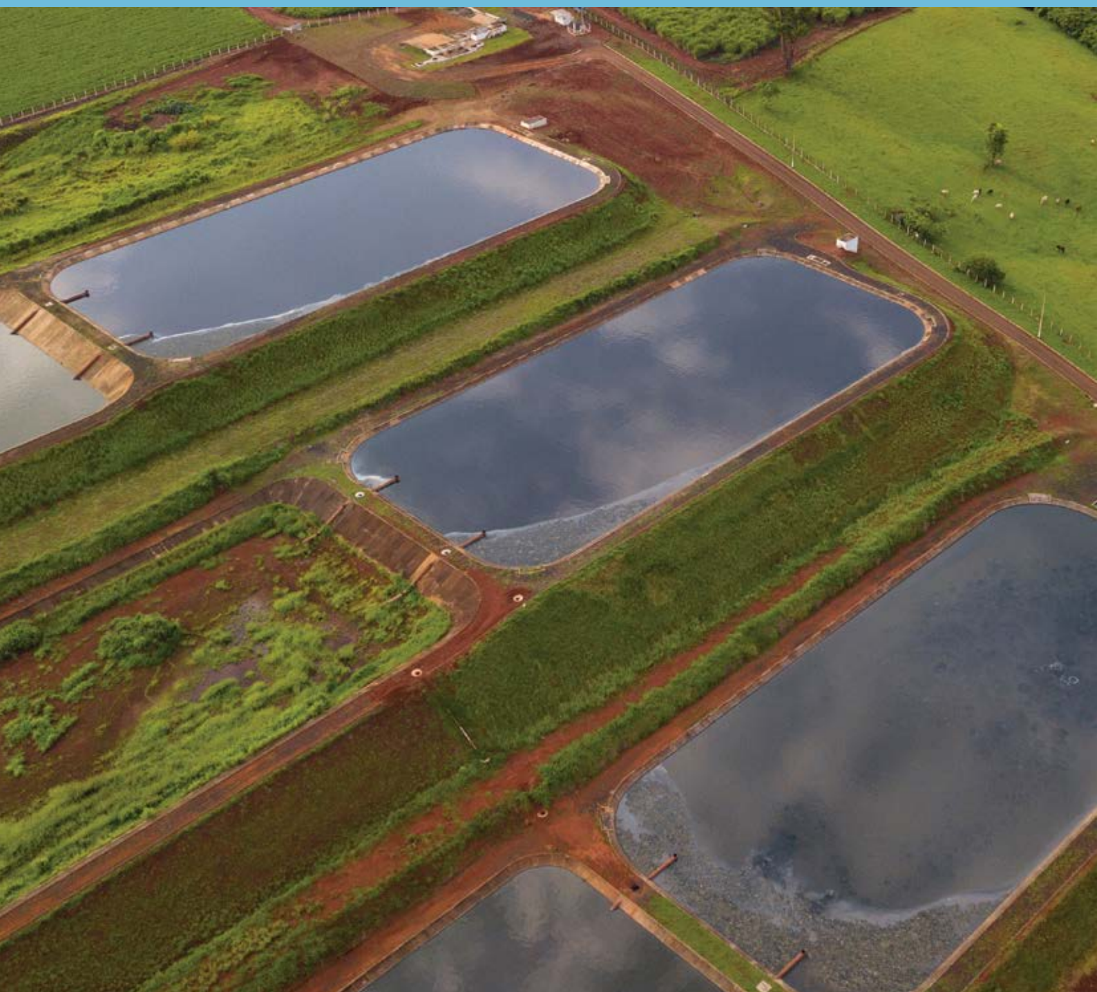
Vista aérea de una planta de tratamiento de aguas residuales.
