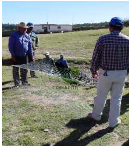
Figura 28. Armado de cajones de malla
