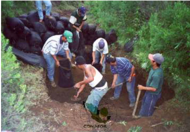
Figura 73. Llenado de geocostales con tierra extraída de la zanja
