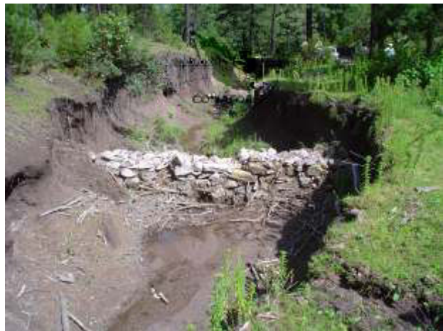
Figura 55. Acomodo de piedras en una cárcava pequeña
