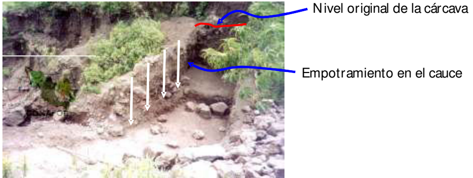
Figura 87. Empotramiento en el cauce
