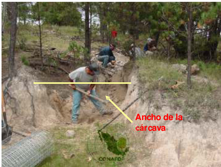
Figura 26. Excavación de zanja dentro de la cárcava para empotrar la presa
