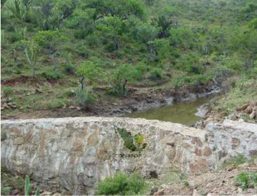
Figura 86. Presa de mampostería
