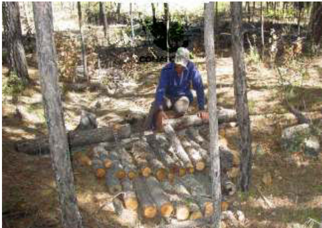
Figura 41. Formación de delantal utilizando trozos de morillos
