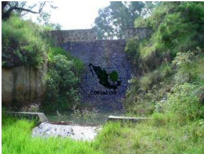
Figura 93. Paredes de la presa y vertedor
