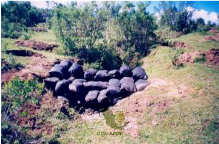
Figura 74. Diseño de presa de geocostales en una cárcava
