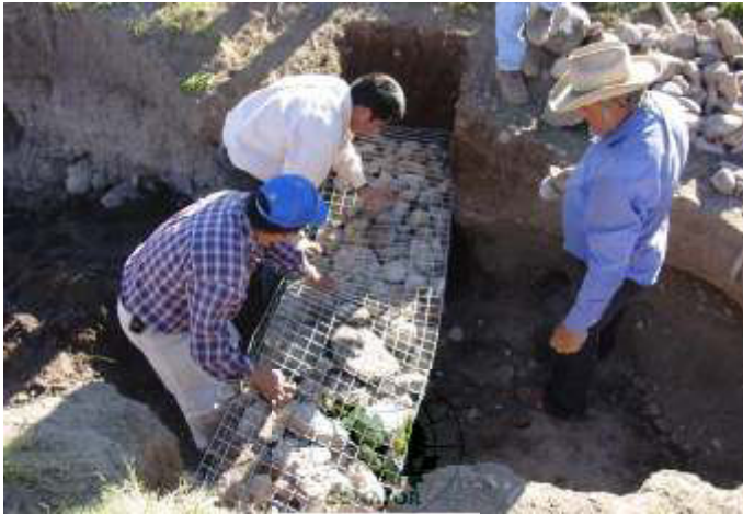
Figura 31. Cierre de cajón con alambre
