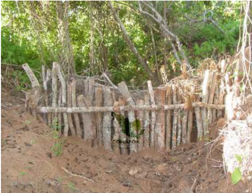
Figura 43. Presa de ramas
