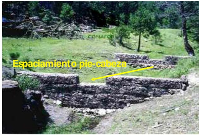
Figura 23. Diseño de espaciamiento entre presas de malla
