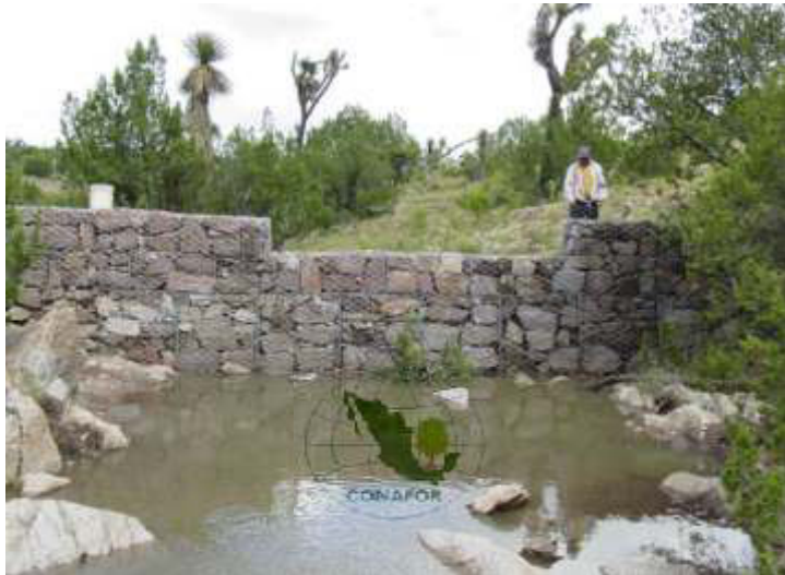
Figura 94. Presa de gaviones
