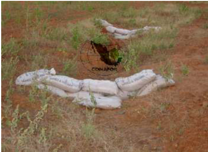
Figura 67. Formación de presa de costales en una cárcava
