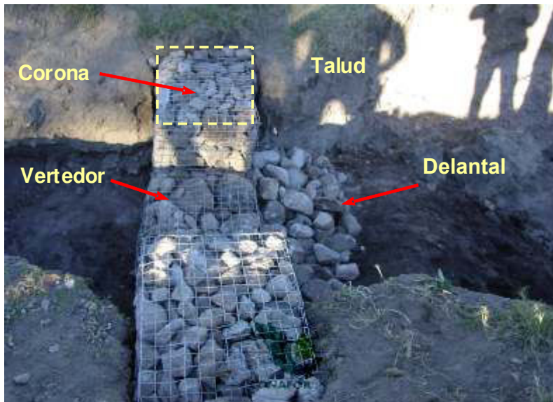
Figura 25. Vertedor en una presa de malla
