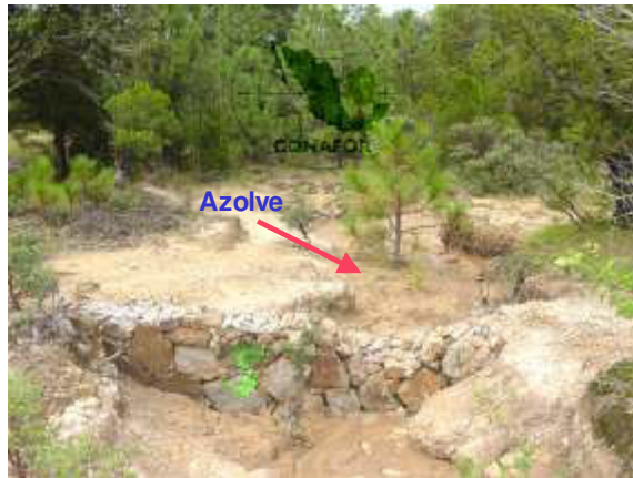
Figura 61. Retención de azolves en una presa de piedra acomodada
