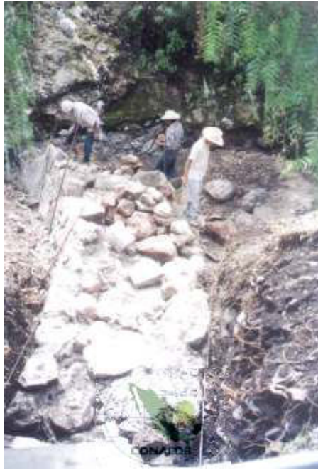
Figura 92. Conformación del empotramiento y la base
