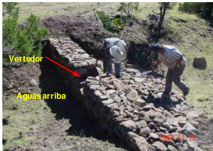
Figura 58. Formación del delantal
