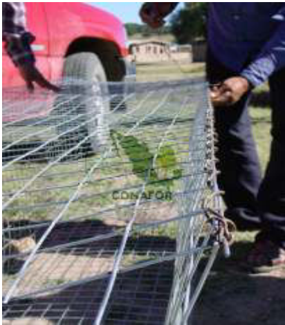
Figura 27. Unión de paredes de malla
