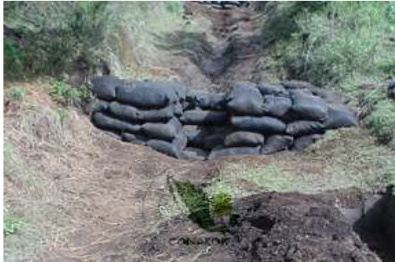
Figura 71. Presa de geocostales
