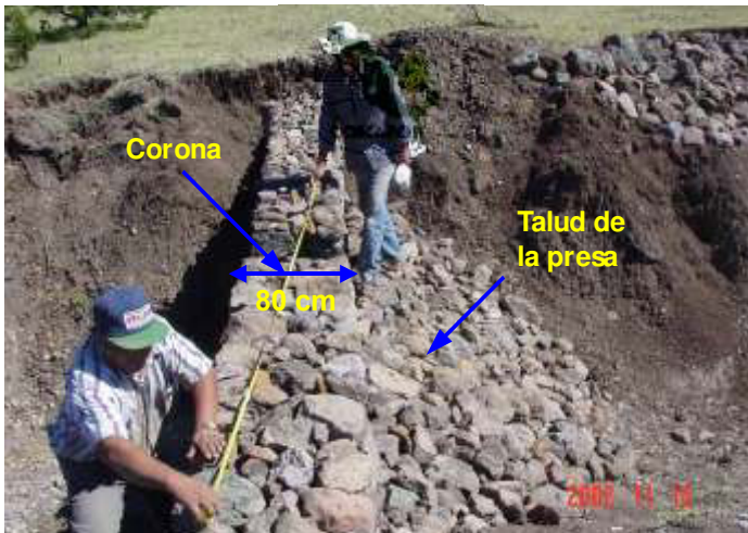
Figura 57. Vista lateral de una presa de piedra acomodada
