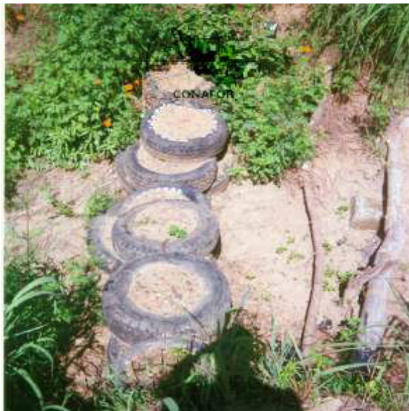
Figura 80. Formación de presa con una hilera de llantas
