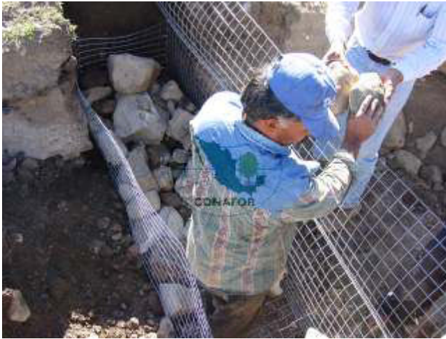
Figura 29. Llenado de cajones con piedra
