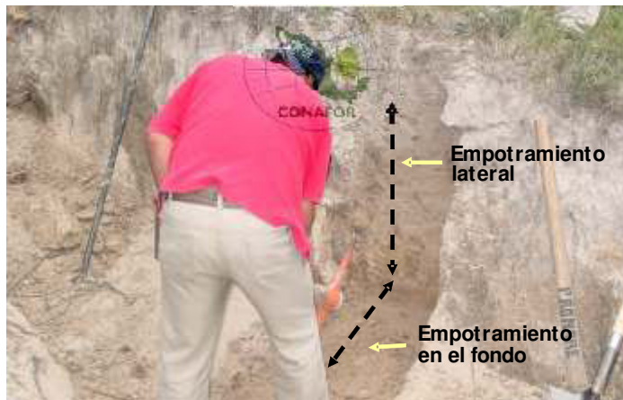
Figura 24. Excavación de zanja para empotramiento de la estructura
