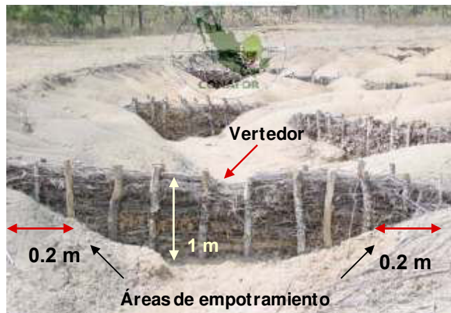
Figura 47. Diseño de presa de ramas en cárcavas
