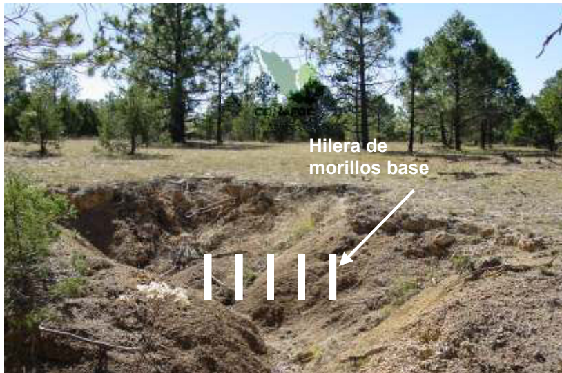
Figura 38. Establecimiento de hilera de morillos base
