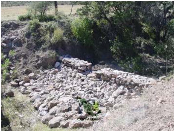
Figura 50. Presa de piedra acomodada
