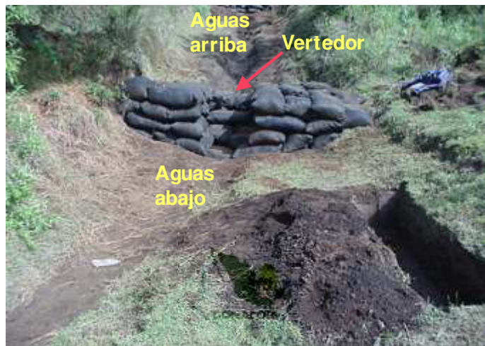
Figura 75. Presa de geocostales con vertedor en una cárcava
