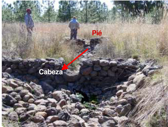
Figura 59. Espaciamiento pie-cabeza entre presas de piedra acomodada
