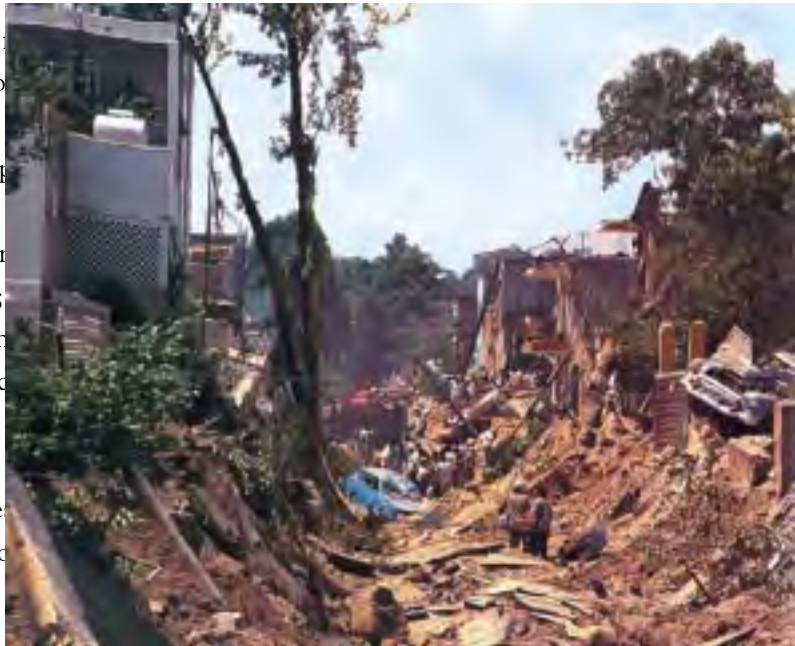
Figura 3. Daño por explosiones en Guadalajara
