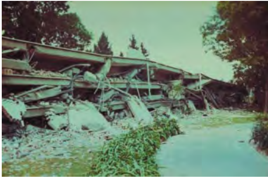
Figura 17. Daños en la Universidad Iberoamericana durante un sismo en 1979
