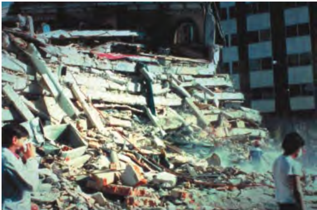
Figura 1. Colapso de edificio en la Ciudad de México durante el sismo de 1985
