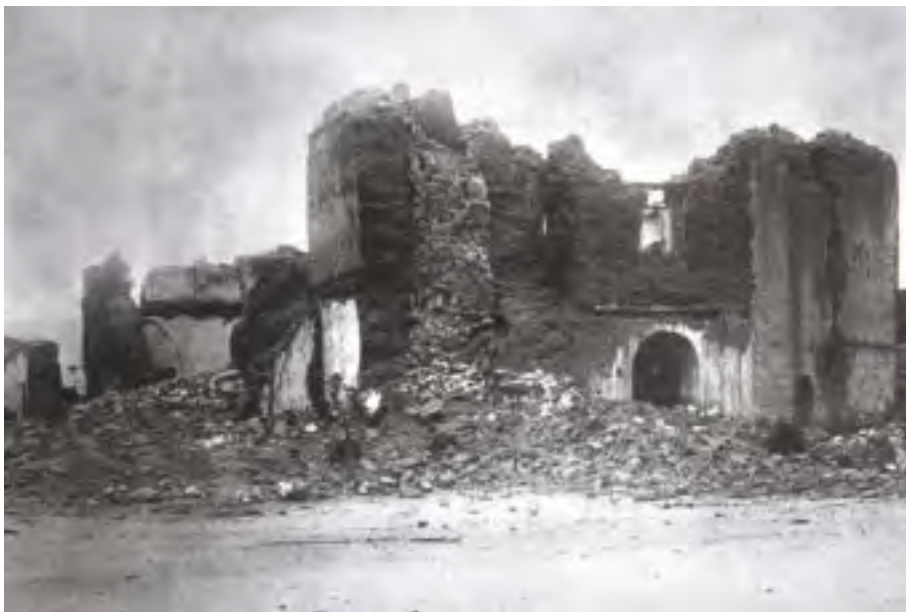
Figura 16. Daños ocasionados por el sismo de Bavispe, Sonora en 1887
