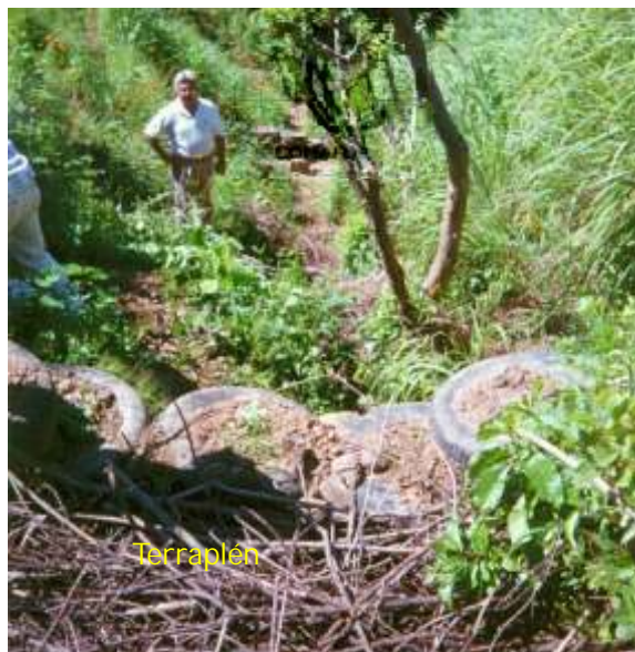
Figura 84. Presa de llantas con ramas aguas arriba de la presa
