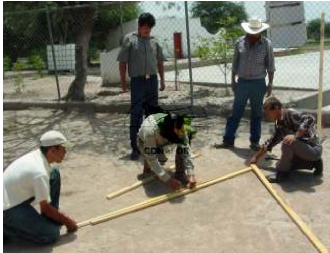
Figura 4. Unión de los palos base marcado para colocar el travesaño
