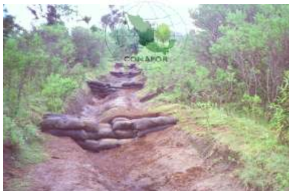
Figura 78. Distribución espacial de presas de geocostales en una cárcava
