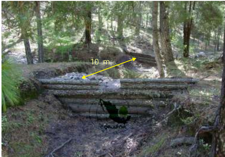
Figura 37. Distribución espacial de presas de morillos en áreas forestales
