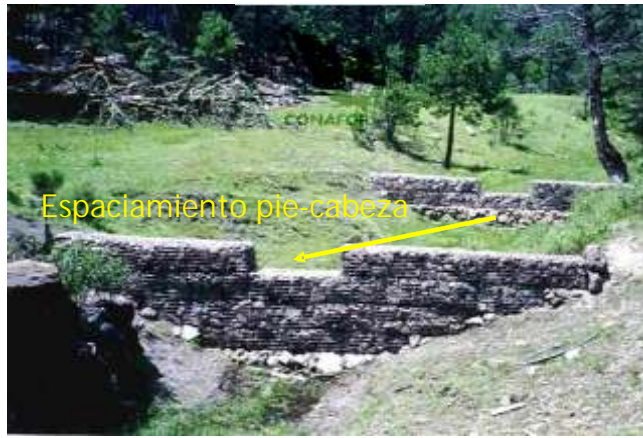
Figura 23. Diseño de espaciamiento entre presas de malla
