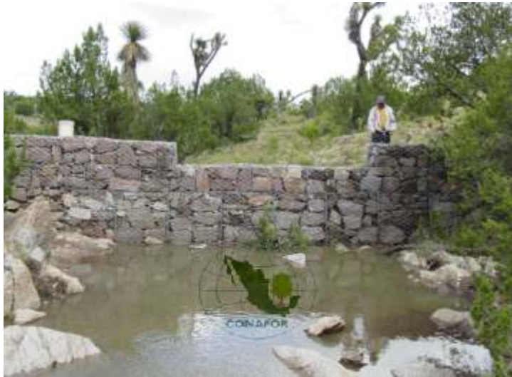
Figura 94. Presa de gaviones
