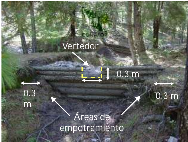
Figura 40. Colocación transversal de morillos y formación del vertedor en una presa
