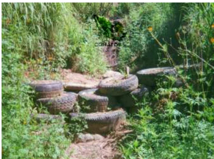
Figura 81. Acomodo de llantas en la formación de la presa
