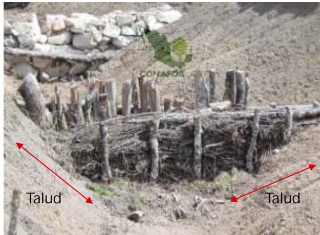
Figura 46. Presa de ramas con doble hilera de estacas base
