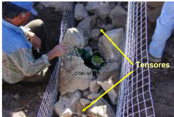
Figura 30. Colocación de tensores en el llenado de cajones
