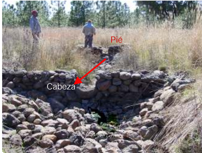
Figura 59. Espaciamiento pie-cabeza entre presas de piedra acomodada
