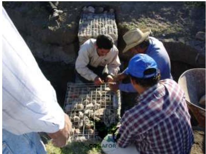
Figura 32. Formación del vertedor en la presa de malla
