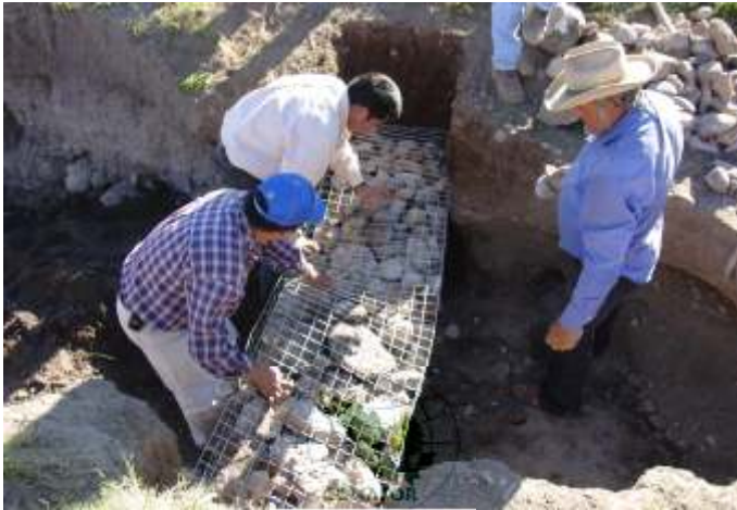
Figura 31. Cierre de cajón con alambre
