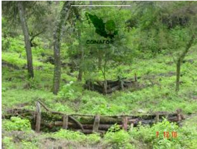
Figura 48. Aprovechamiento de ramas producto de incendios para construcción de presas
