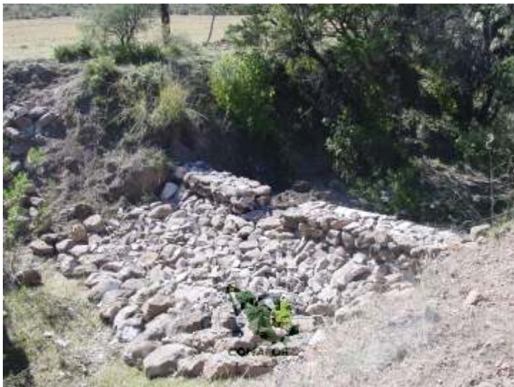
Figura 50. Presa de piedra acomodada
