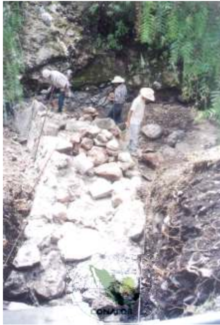
Figura 92. Conformación del empotramiento y la base
