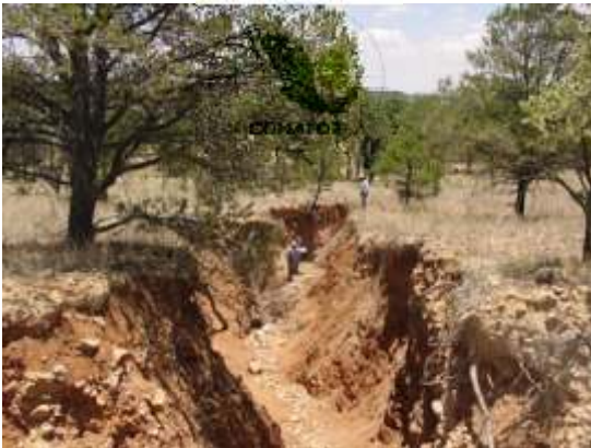
Figura 35. Localización de cárcava en áreas forestales
