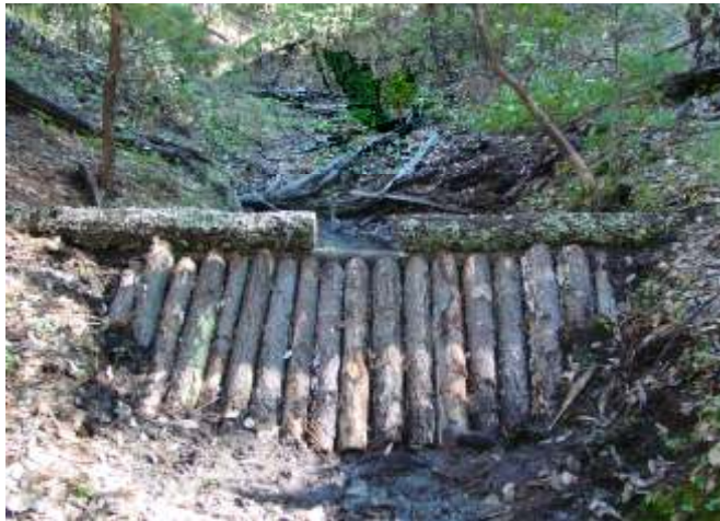
Figura 34. Presa de morillo
