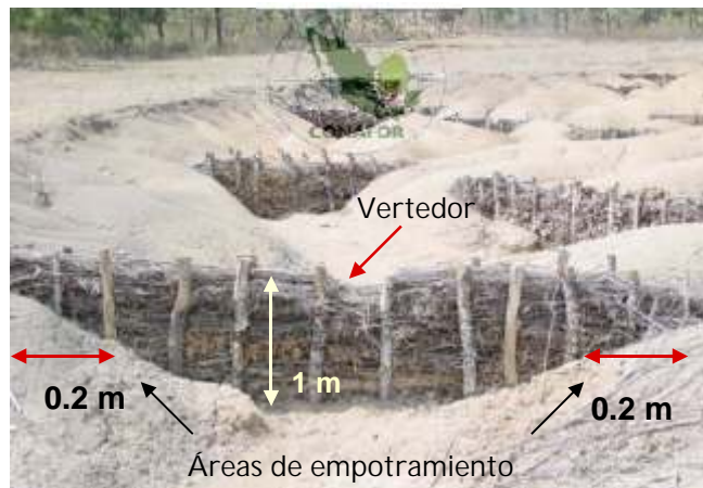
Figura 47. Diseño de presa de ramas en cárcavas
