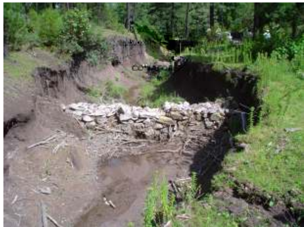
Figura 55. Acomodo de piedras en una cárcava pequeña
