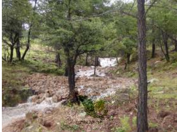
Figura 62. Filtración de agua a través de presas de piedra acomodada
