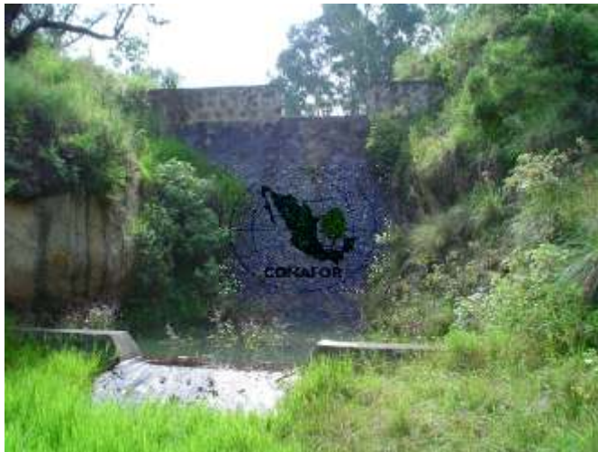
Figura 93. Paredes de la presa y vertedor
