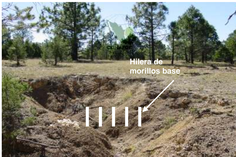
Figura 38. Establecimiento de hilera de morillos base
