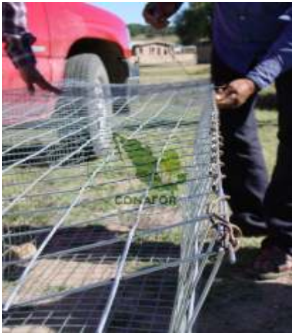
Figura 27. Unión de paredes de malla
