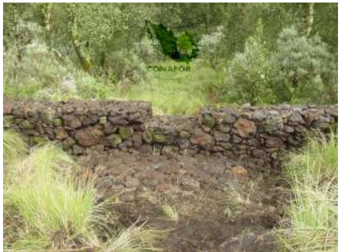
Figura 53. Colocación de piedras en la construcción de una presa
