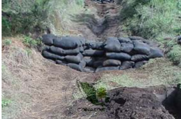
Figura 71. Presa de geocostales
