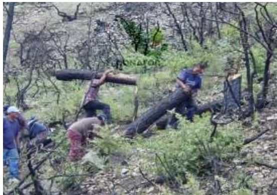
Figura 36. Aprovechamiento de productos de incendios forestales para elaborar presas de morillos
