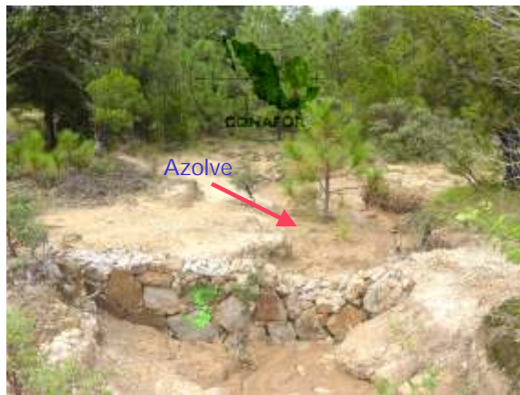
Figura 61. Retención de azolves en una presa de piedra acomodada
