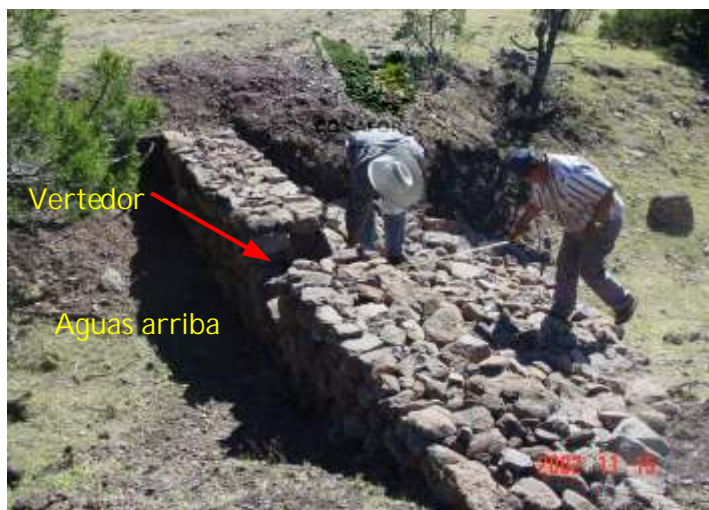
Figura 58. Formación del delantal
