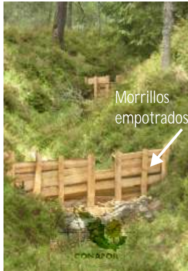
Figura 39. Vista frontal del vertedor en una presa de morillos
