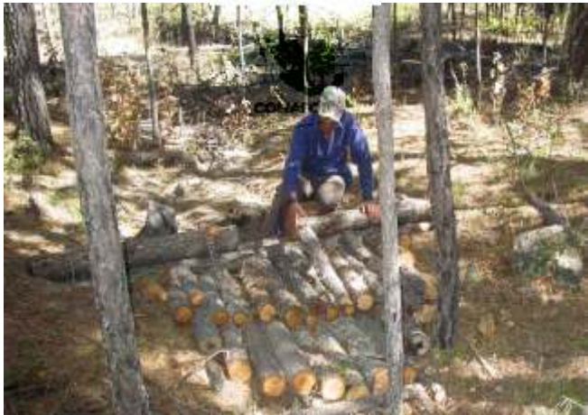
Figura 41. Formación de delantal utilizando trozos de morillos
