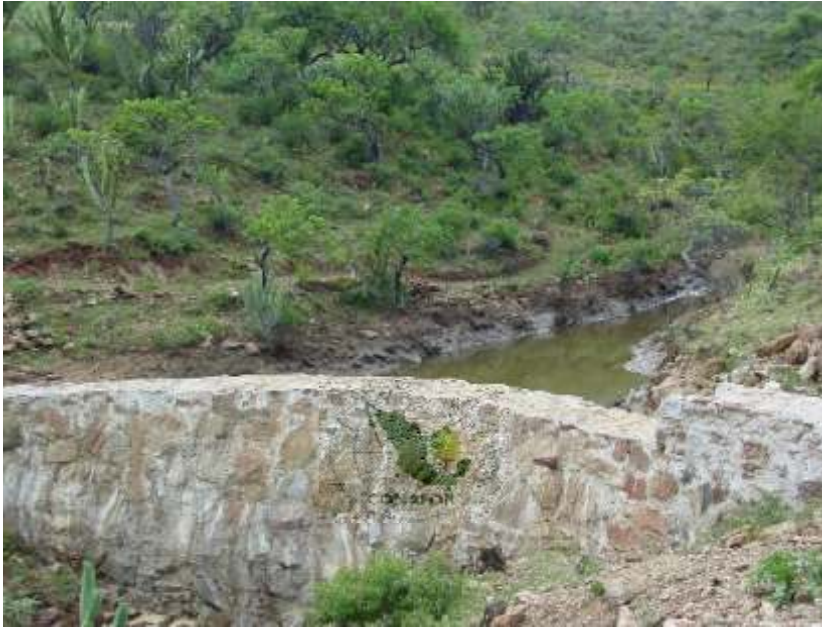
Figura 86. Presa de mampostería
