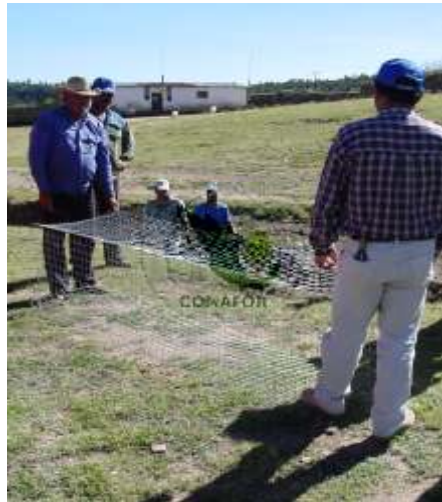
Figura 28. Armado de cajones de malla
