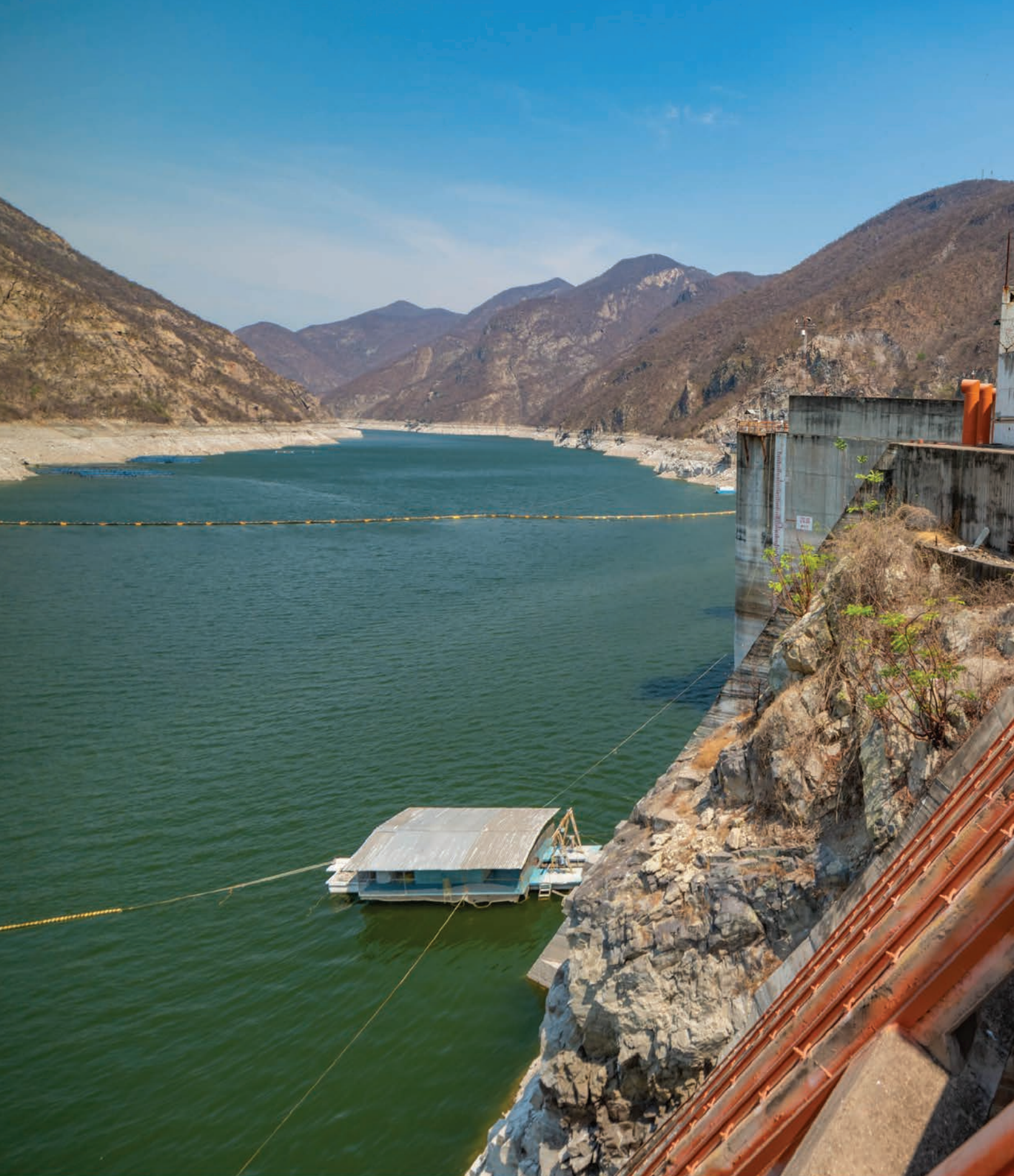
Central hidroeléctrica, Coahuayutla, Guerrero. Comisión Federal de Electricidad.
