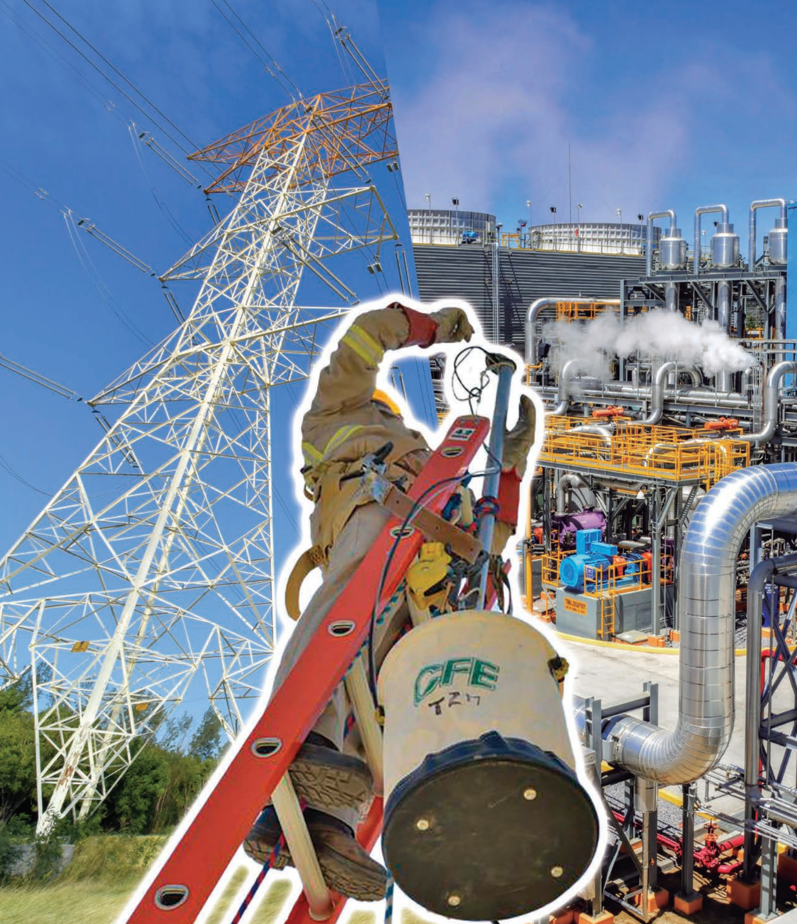
Torre de transmisión, Alto Lucero, Veracruz. Central geotérmica, Chignautla, Puebla. Comisión Federal de Electricidad.
