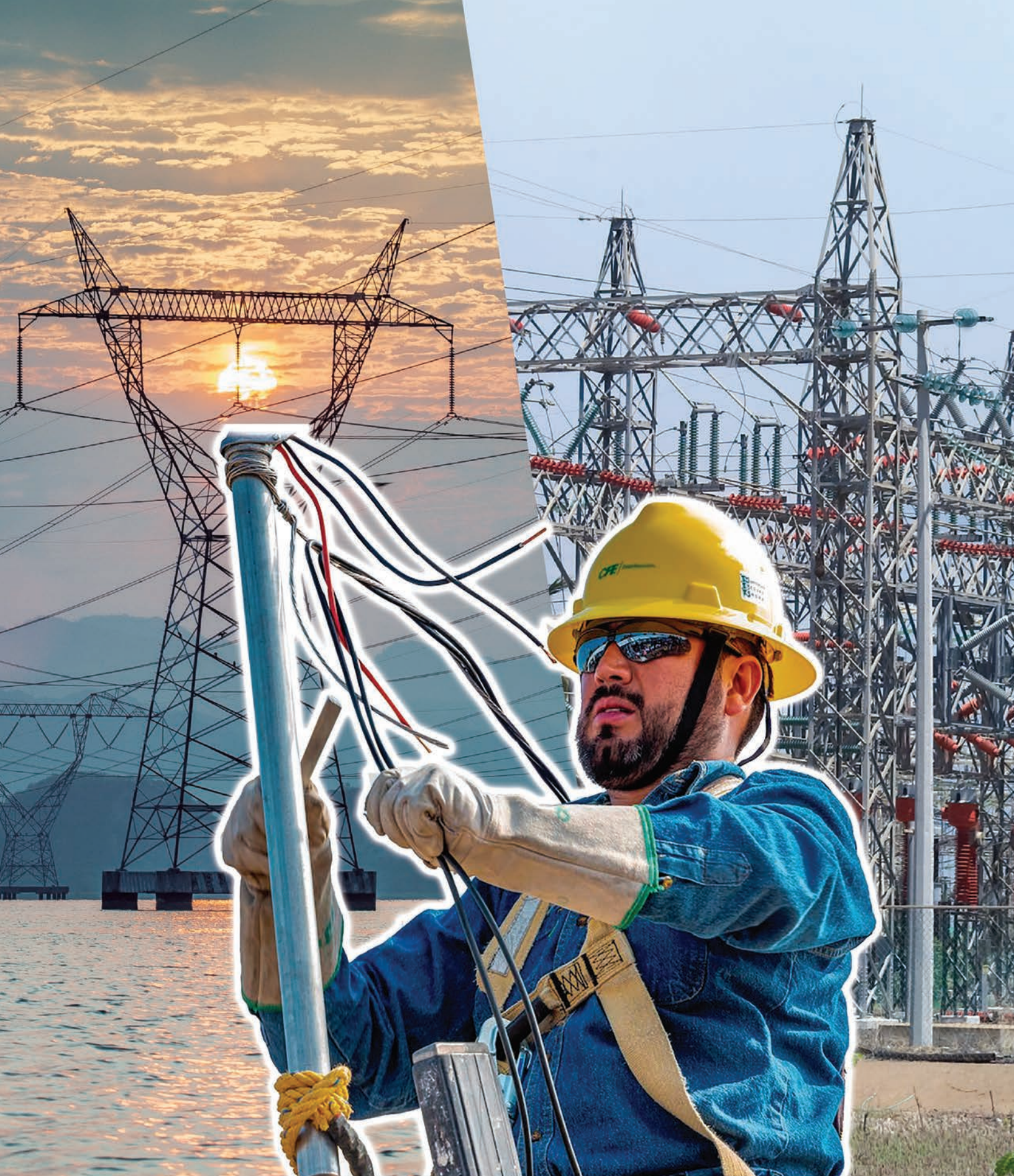
Torre de transmisión, Manzanillo, Colima. Subestación eléctrica, Tuxpan, Veracruz. Comisión Federal de Electricidad.
